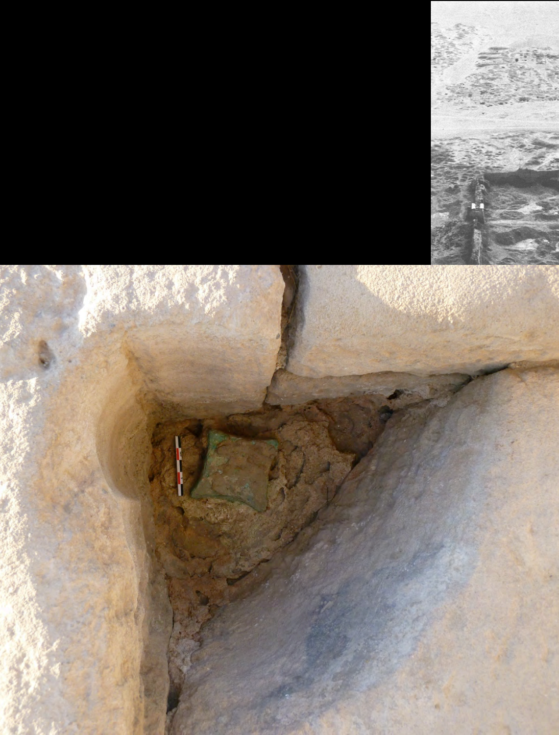
DENDARA, MAMMISI « ROMAIN » support en alliage cuivreux de rotation de pivot de porte
